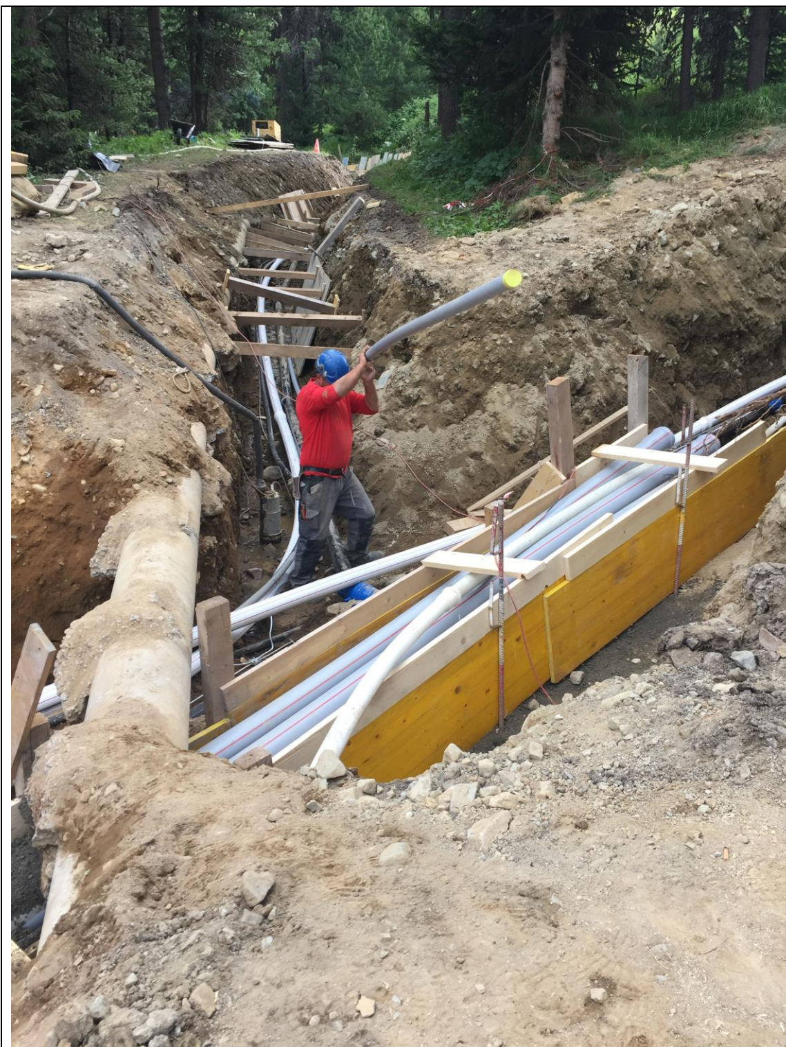
Abb.: Verlegung von Rohren im Bereich Nachtloipe (Bauamt St. Moritz)
