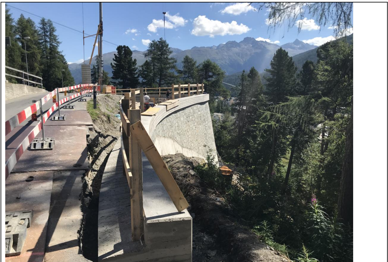
Abb.: Bau der Stützmauer Palüd im Bereich der Einfahrt in die Via Palüd (af Toscano)
