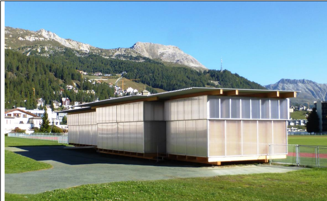
Abb.: Fertiges Höhentrainingscenter – Mobiler Teil (Bauamt St. Moritz)
