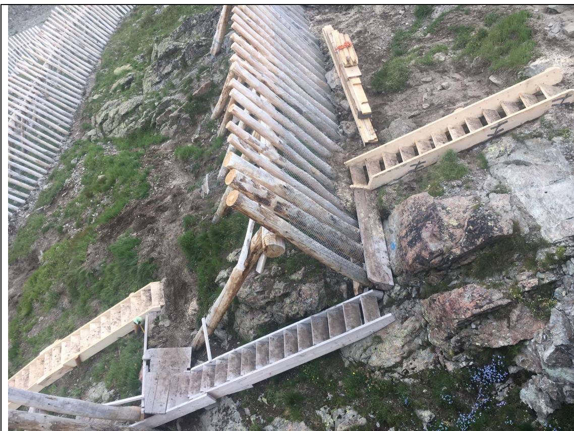
Abb.: Treppen für Vertical Race zwischen den Lawinerverbauungen unterhalb des Herrenstarts (Bauamt St. Moritz)
