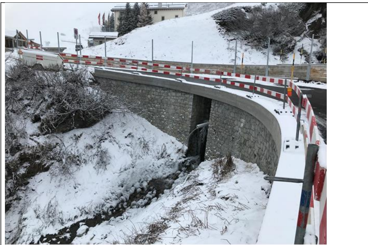
Abb.: Sanierte Strassenbrücke Salastrains (af Toscano)
