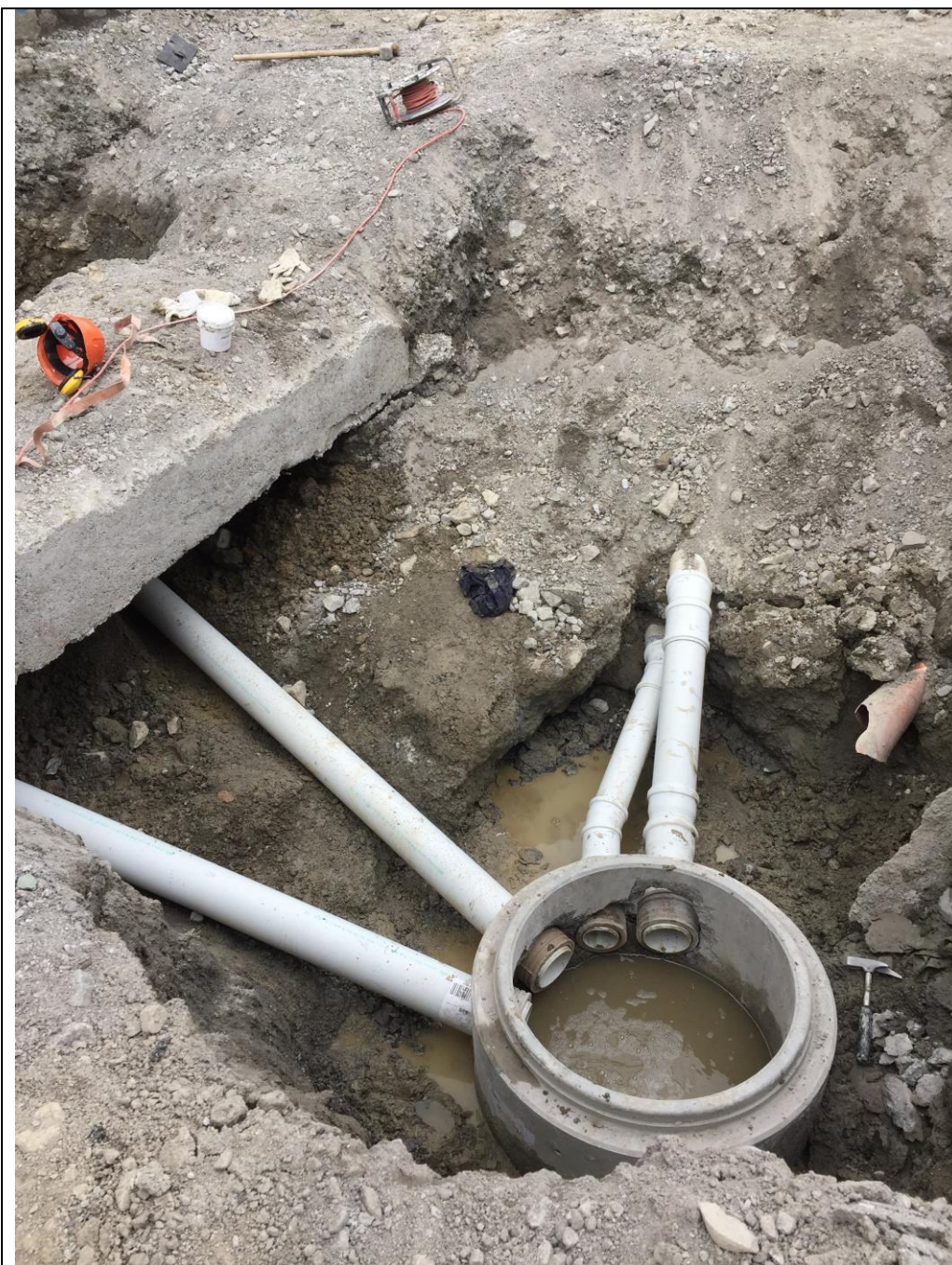
Abb.: Neu angelegter Sammelschacht in der Via Aruons (Bauamt St. Moritz)
