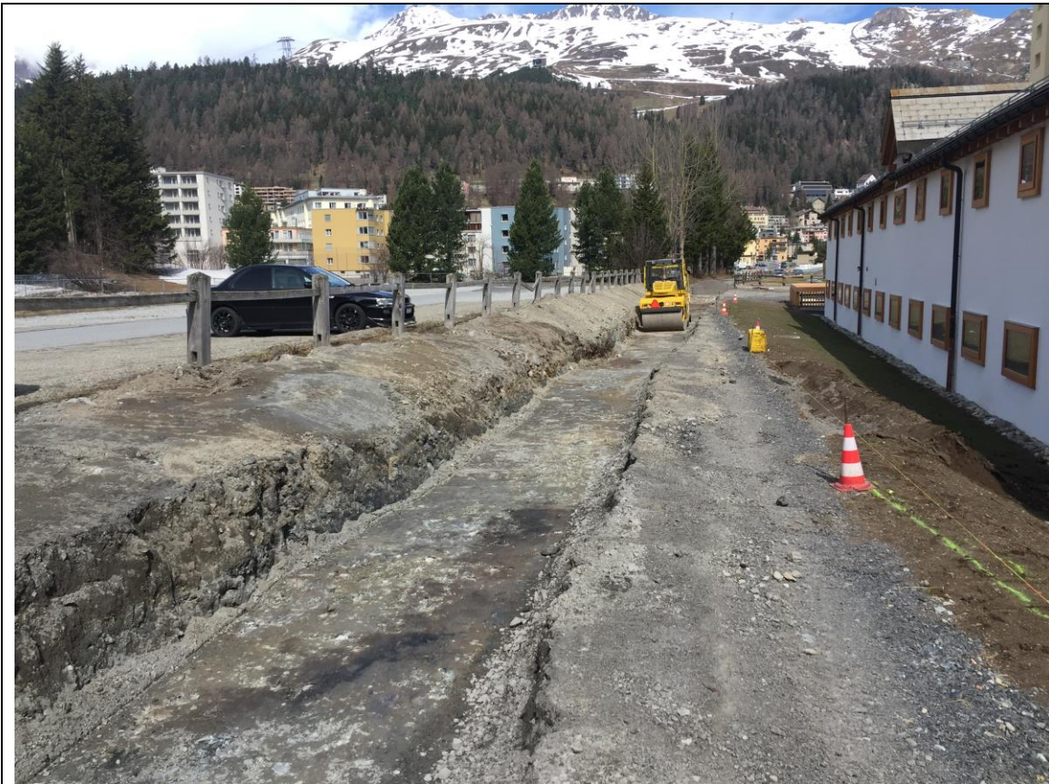
Abb.: Sanierung der Zufahrt neben den Polostallungen (Bauamt St. Moritz)
