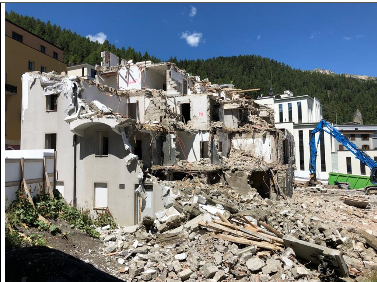
Abb.: Rückbau Hotel Edelweiss (Bauamt St. Moritz)
