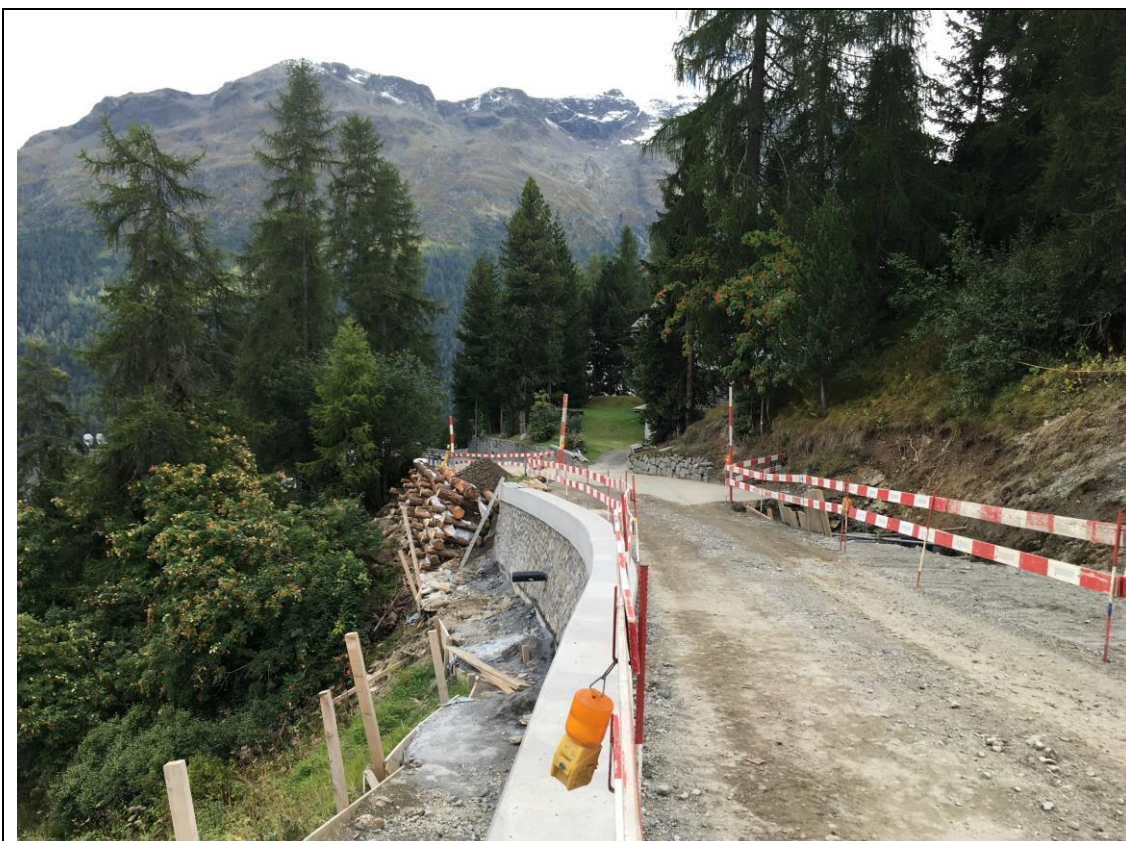
Abb.: Die sanierte Via Tinus mit dem neu erstellten talseitigen Stützbauwerk und dem temporären Holzkasten im Übergangsbereich (Bauamt St. Moritz)
