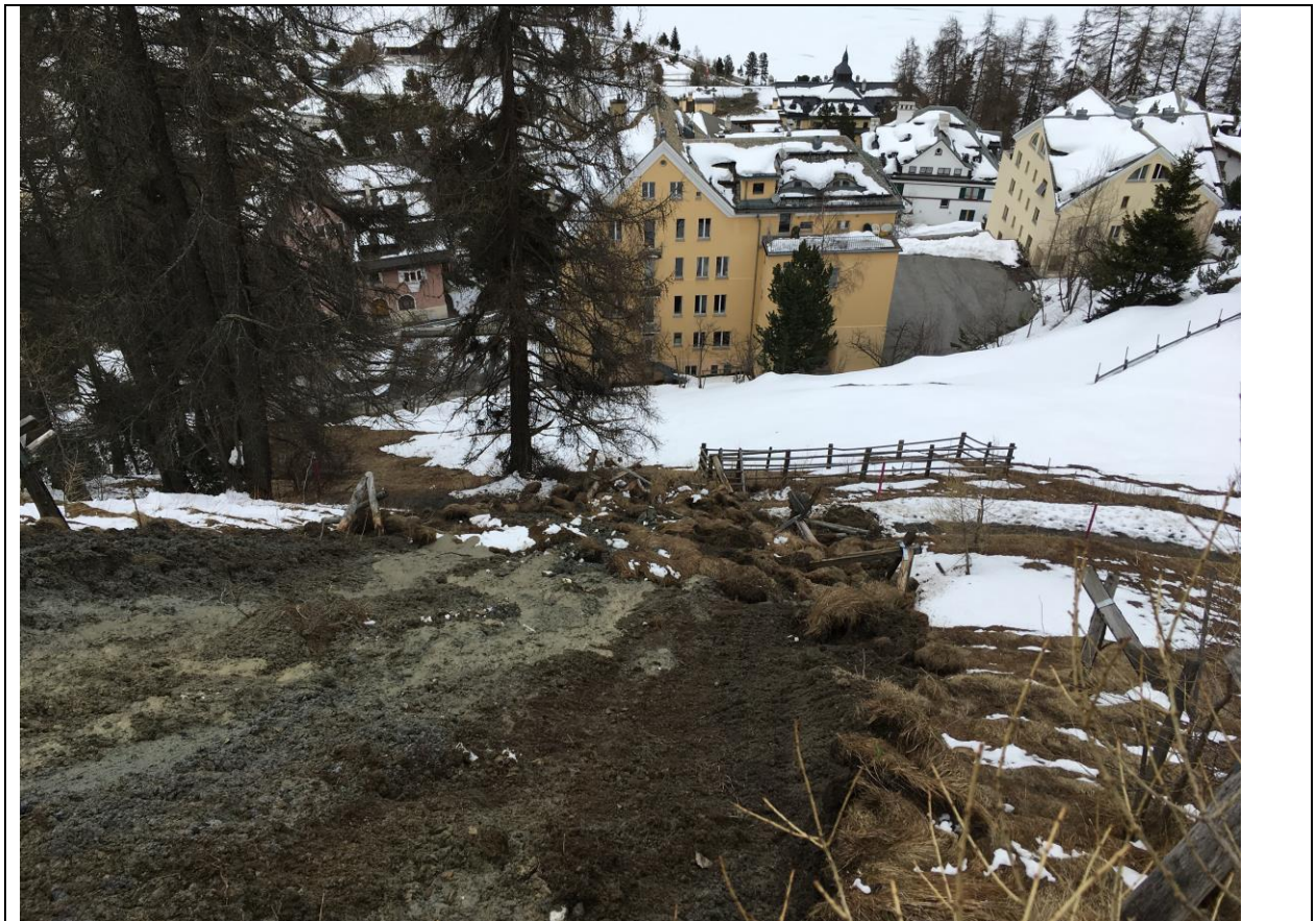
Abb.: Rutschung im Bereich Wasserfallpromenade (Bauamt St. Moritz)
