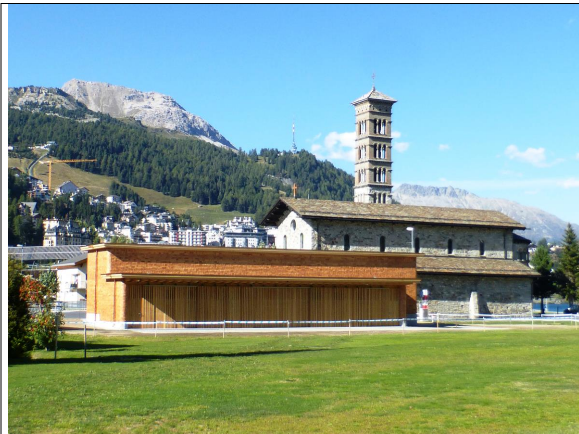
Abb.: Lagergebäude Höhentrainingscenter mit Lagerteil für Sportgeräte (Bauamt St. Moritz)
