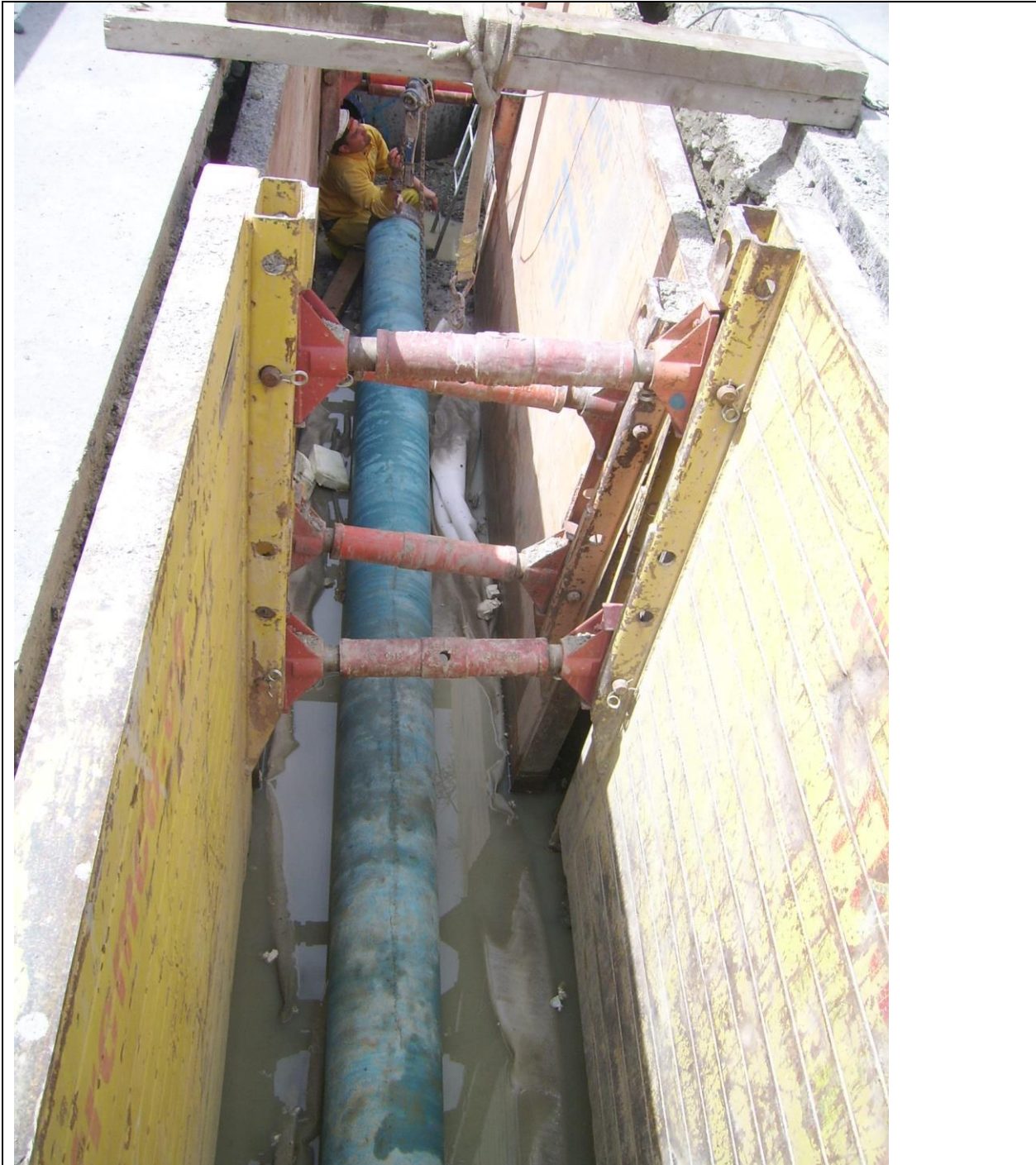
Abb.: Einzug der neuen Leitung in der Giovanni Segantini (Bauamt St. Moritz)
