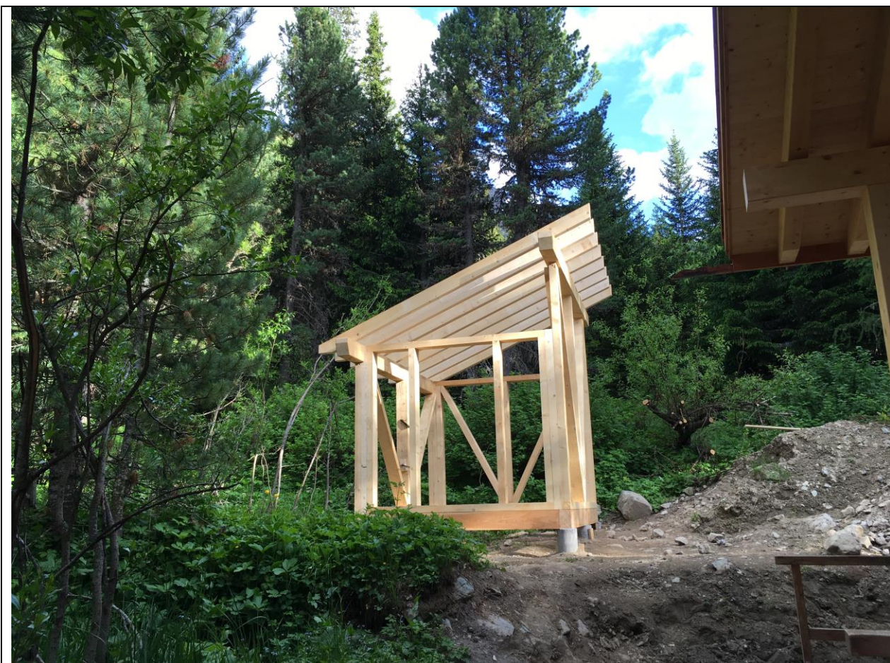
Abb.: Balkenkonstruktion des Brennholzunterstandes vor dessen Einschlagen mit Lärchenbrettern (Bauamt St. Moritz)
