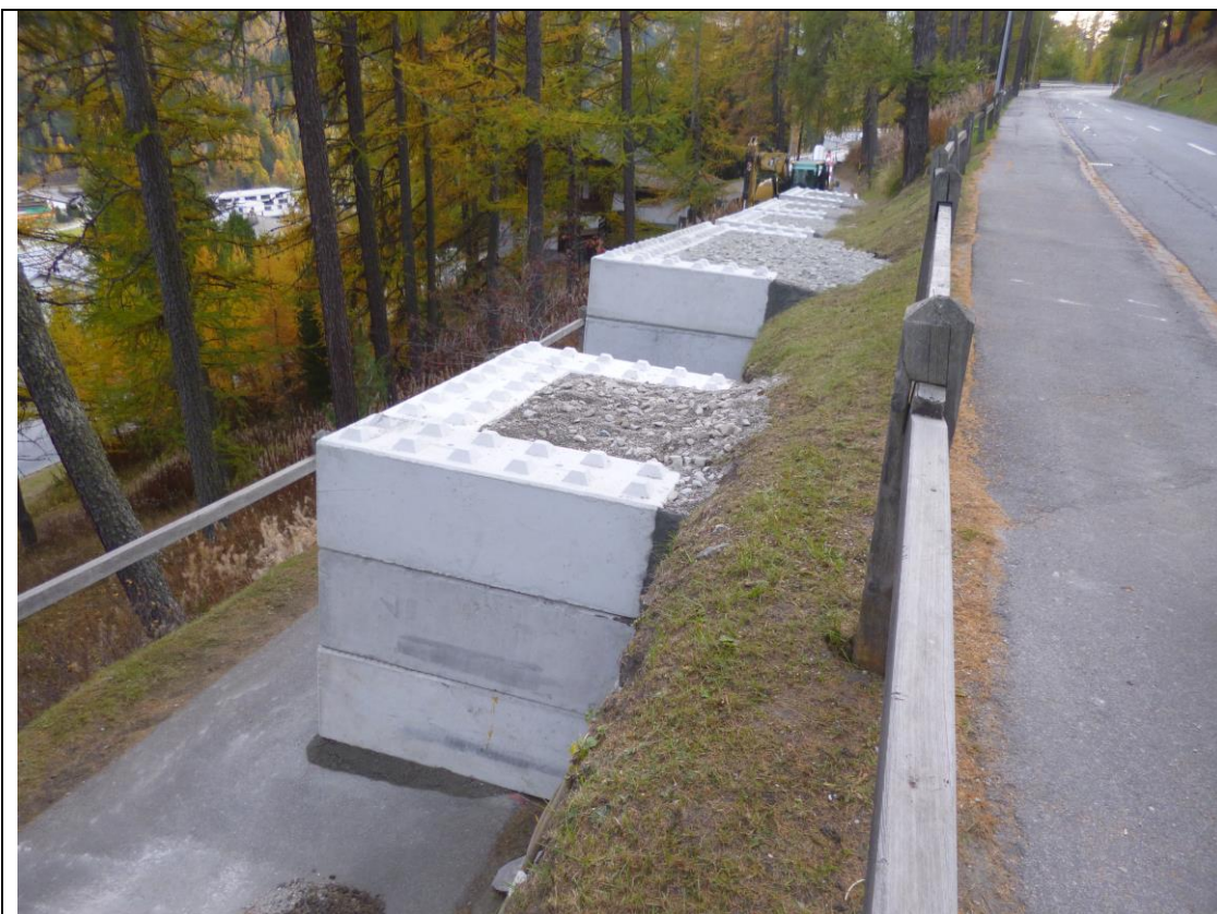
Abb.: Ausgeführte Sicherungsmassnahmen zur Abstützung der talseitigen Stützmauer der Via Somplaz (af Toscano)
