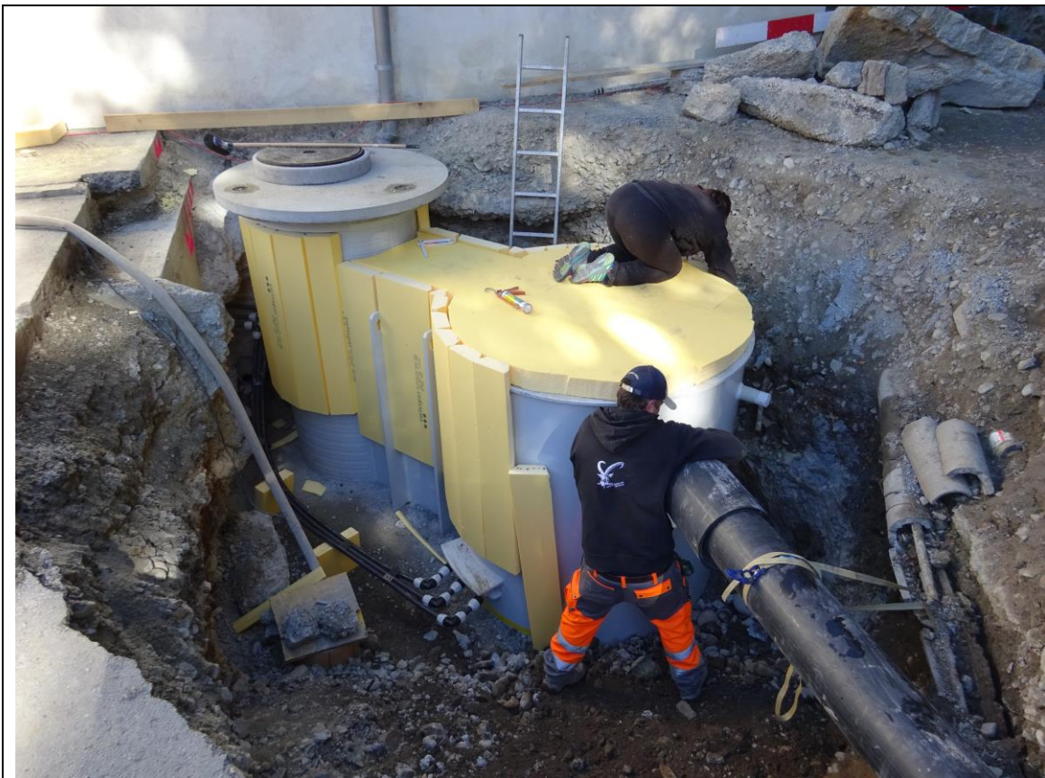
Abb.: Montage des neuen Schachtes neben dem Paracelsus Gebäude (Bauamt St. Moritz)
