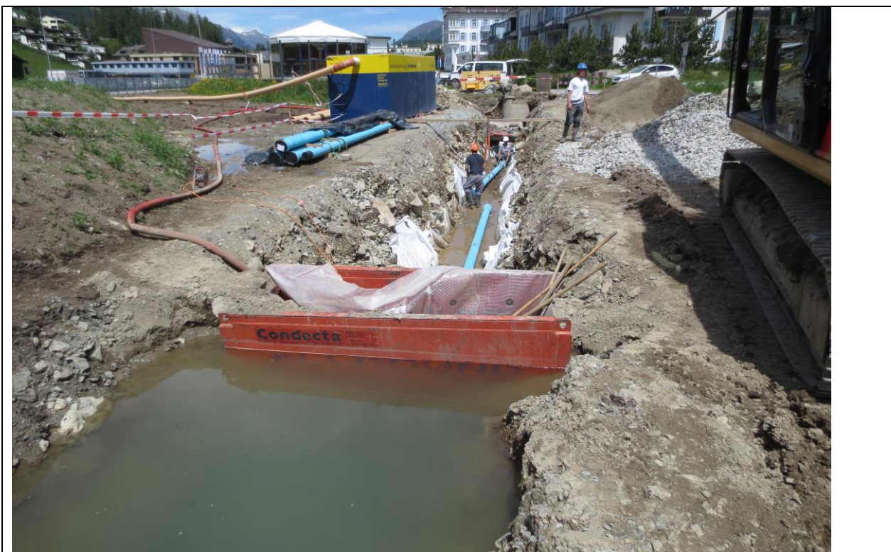
Abb.: Abschnittweise Grabarbeiten wegen des hohen Grundwasserstandes (Bauamt St. Moritz)
