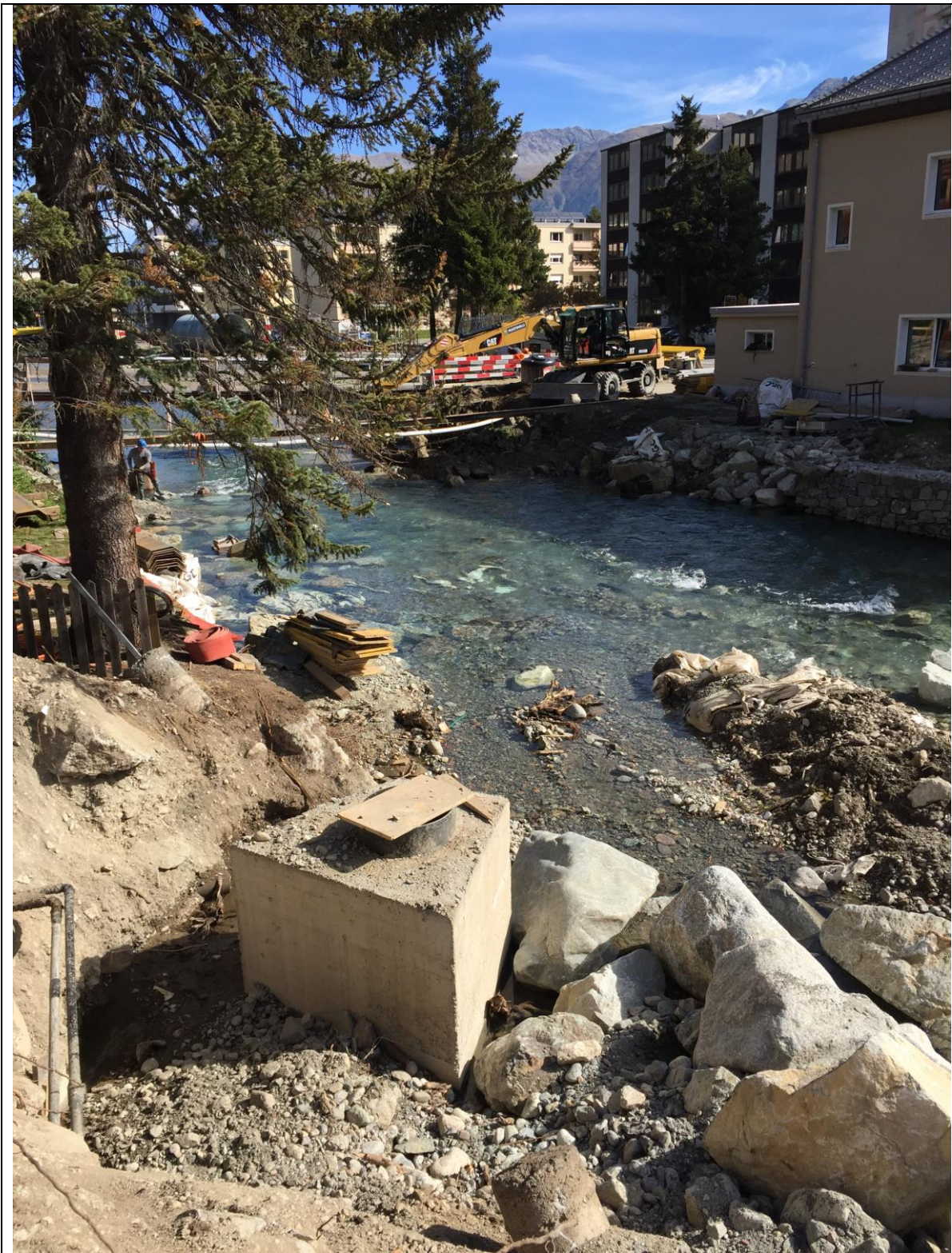
Abb.: Die Erneuerung der Schmutzwasserleitung durch den Inn vom Schacht im Quartier Crasta in Richtung Pumpwerk Lenz (Bauamt St. Moritz)
