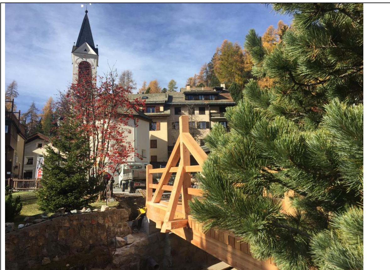
Abb.: Erneuerte Holzbrücke Vallun in Champfèr (Bauamt St. Moritz)
