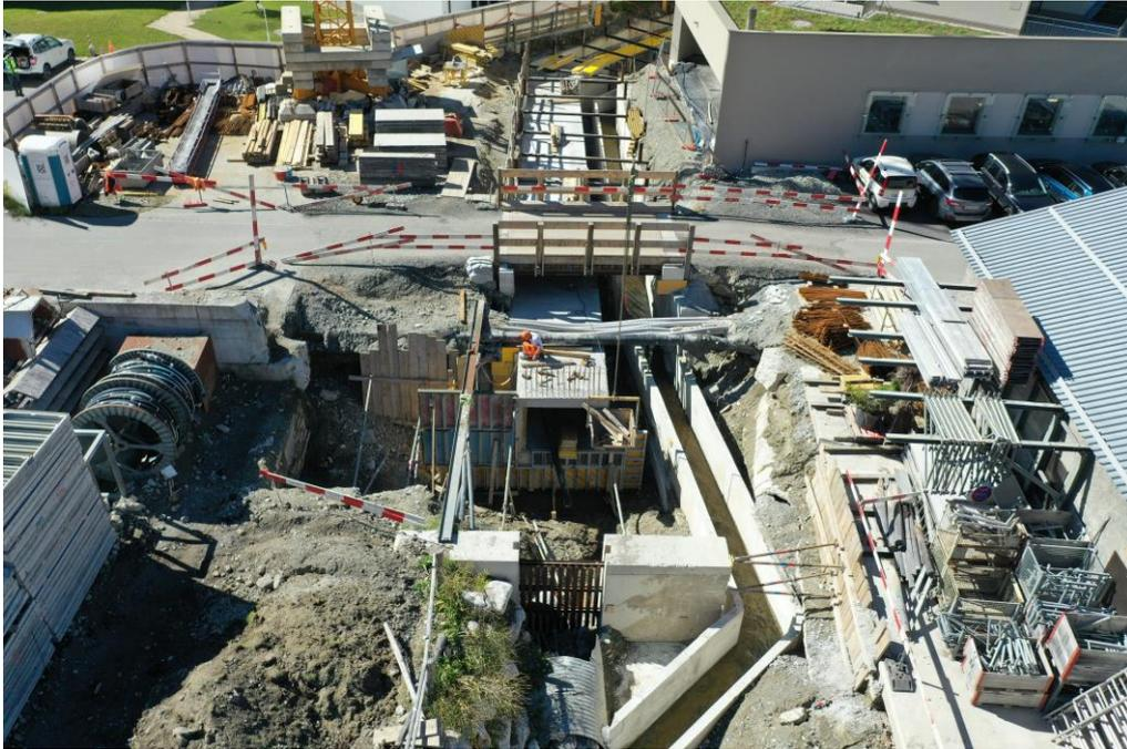
Abb.: Drohnenaufnahme des Abschnitts «Courta» im Bereich der Via Courta mit dem neuen Kanal links und dem Kanal der Wasserhaltung rechts (Bauamt St. Moritz)
