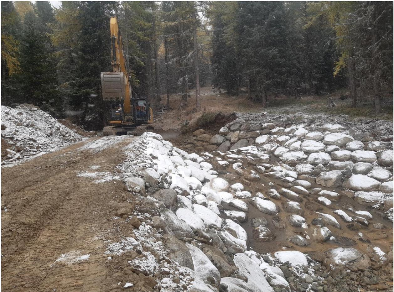
Abb.: Kurz vor Abschluss der Arbeiten am Geschiebefang mit letzten Fertigstellungsarbeiten im Bereich des Einlaufes (Bauamt St. Moritz)
