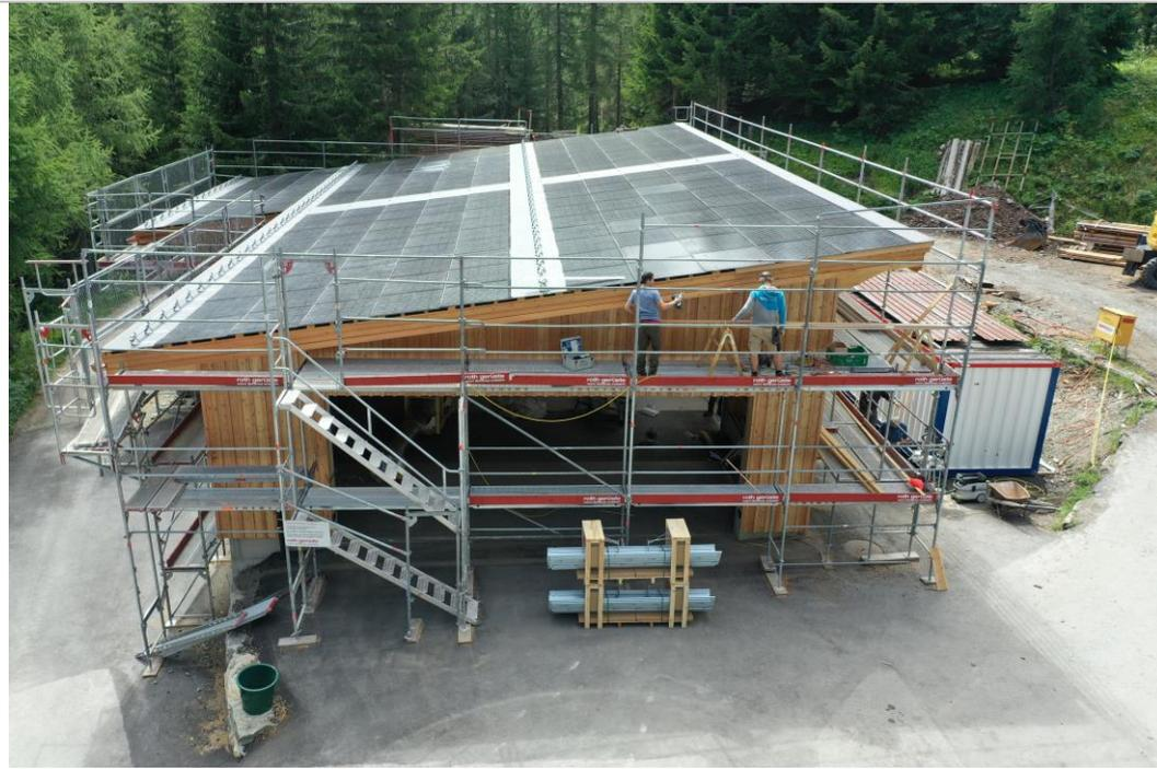
Abb.: Nach der Montage des Solardaches (Bauamt St. Moritz)
