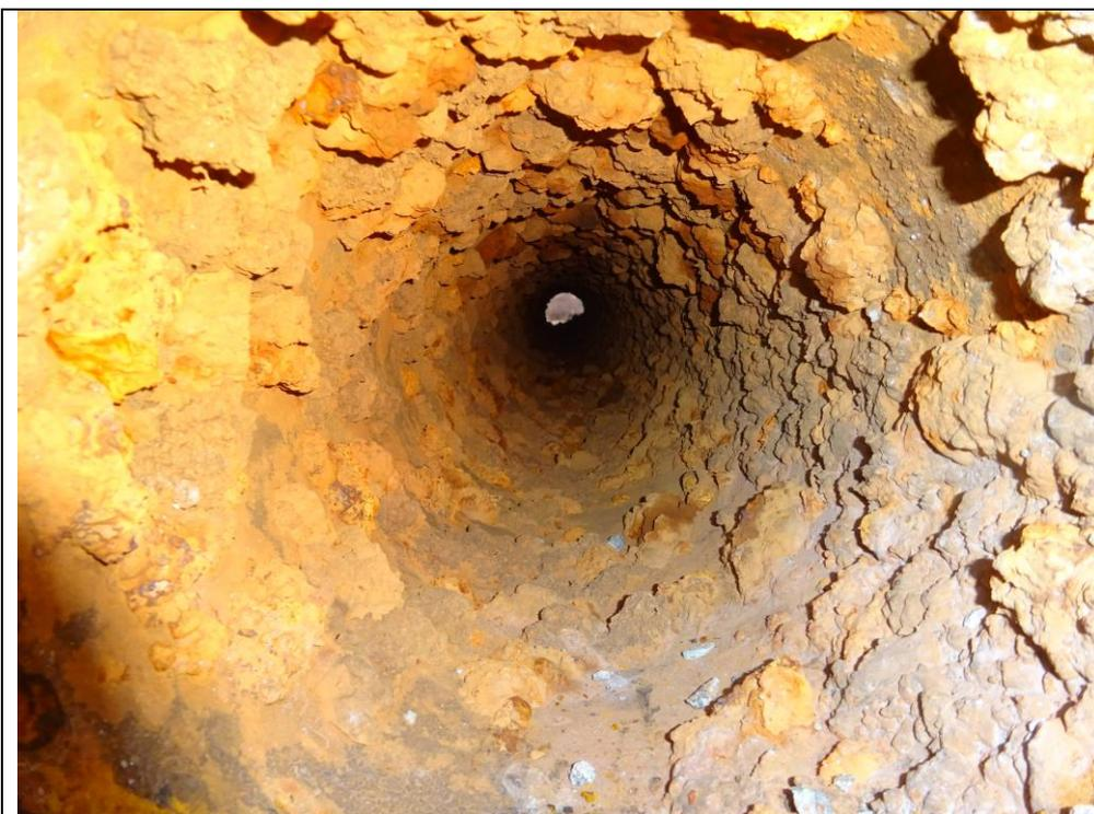
Abb.: Alte, völlig Inkrustierte Leitung, welche ersetzt wurde (Bauamt St. Moritz)
