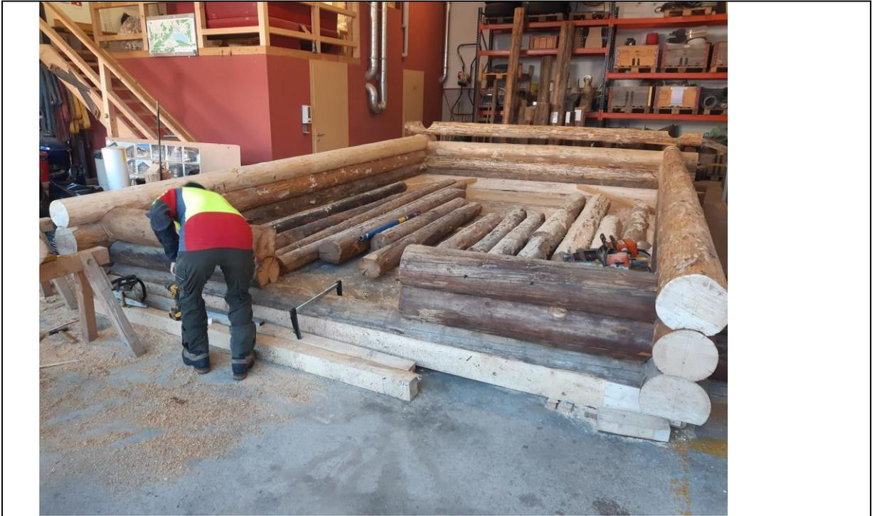
Abb.: Laufende Indoor Sanierung Heidi Hütte. Neue Hölzer und alte Hölzer können noch deutlich an der verschiedenen Farbe unterscheiden werden. Dieser Unterschied wird innerhalb von 2 bis 3 Jahren witterungsbedingt verschwinden. (Bauamt St. Moritz)
