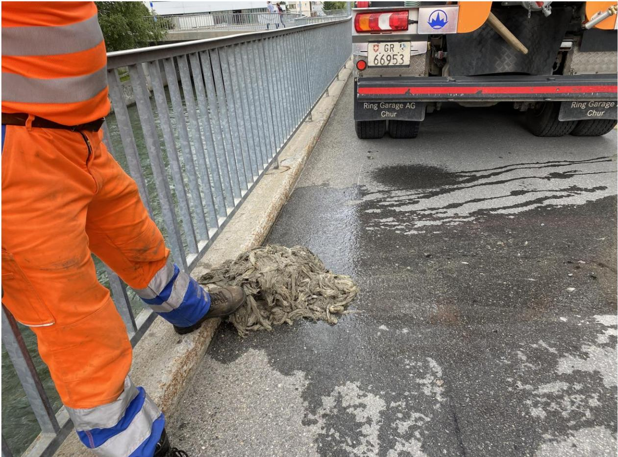
Abb Ein etwa Medizinball grosser Klumpen aus Feuchttücher der im Bereich der der Regenentlastung Corvatsch zu einem Rückstau führte und durch die Mitarbeiter des Spühlwagens entfernt werden musste (Bauamt St. Moritz)
