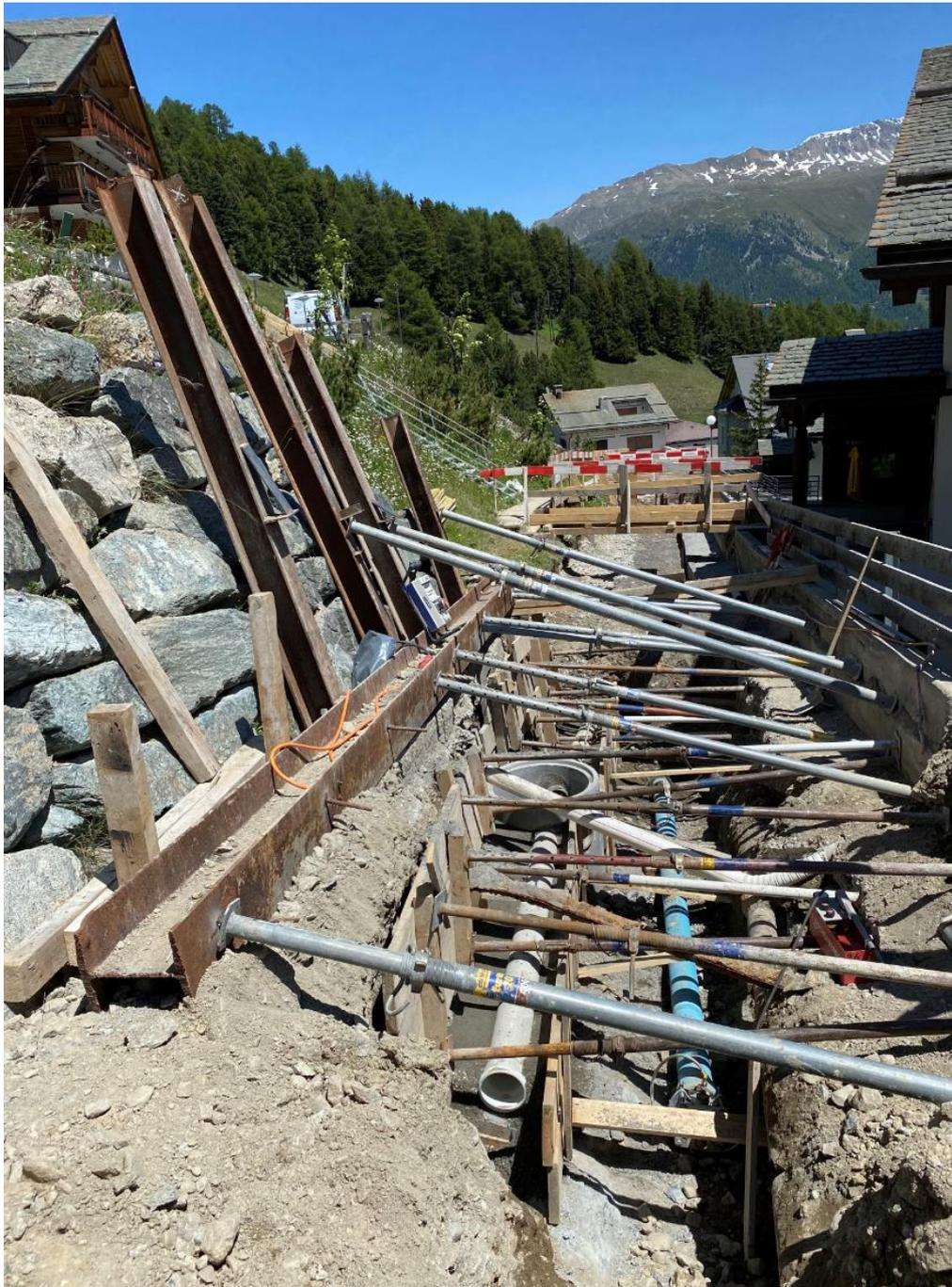
Abb. Mikroetappe zum Schutz der bestehenden Stützbauwerke und zur Gewährleistung der Arbeitssicherheit (Bauamt St. Moritz)
