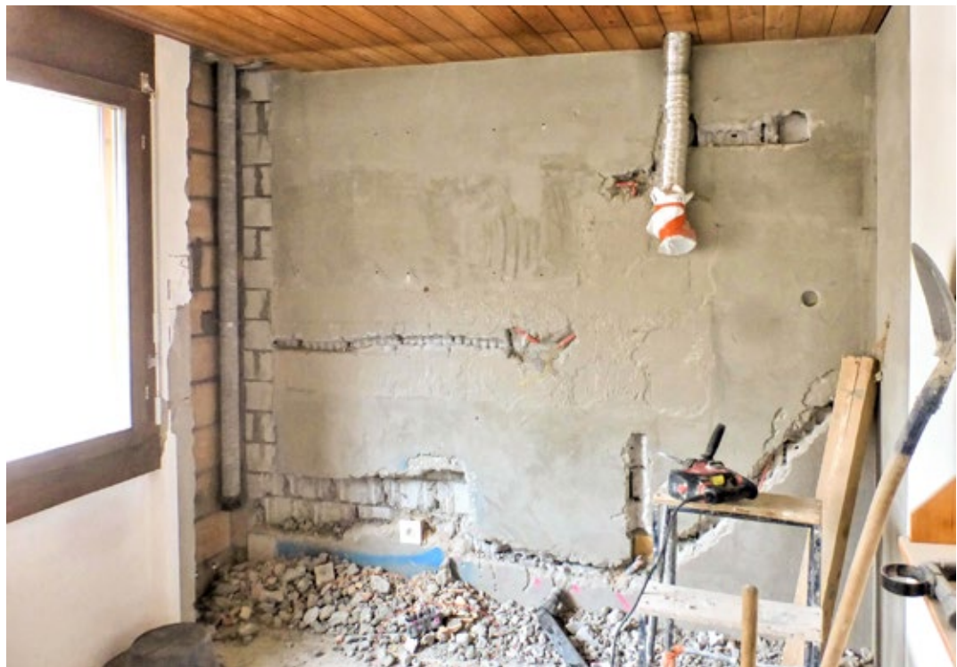
Sanierungsarbeiten Wohntrakt Champfèr (Foto: Bauamt St. Moritz)
