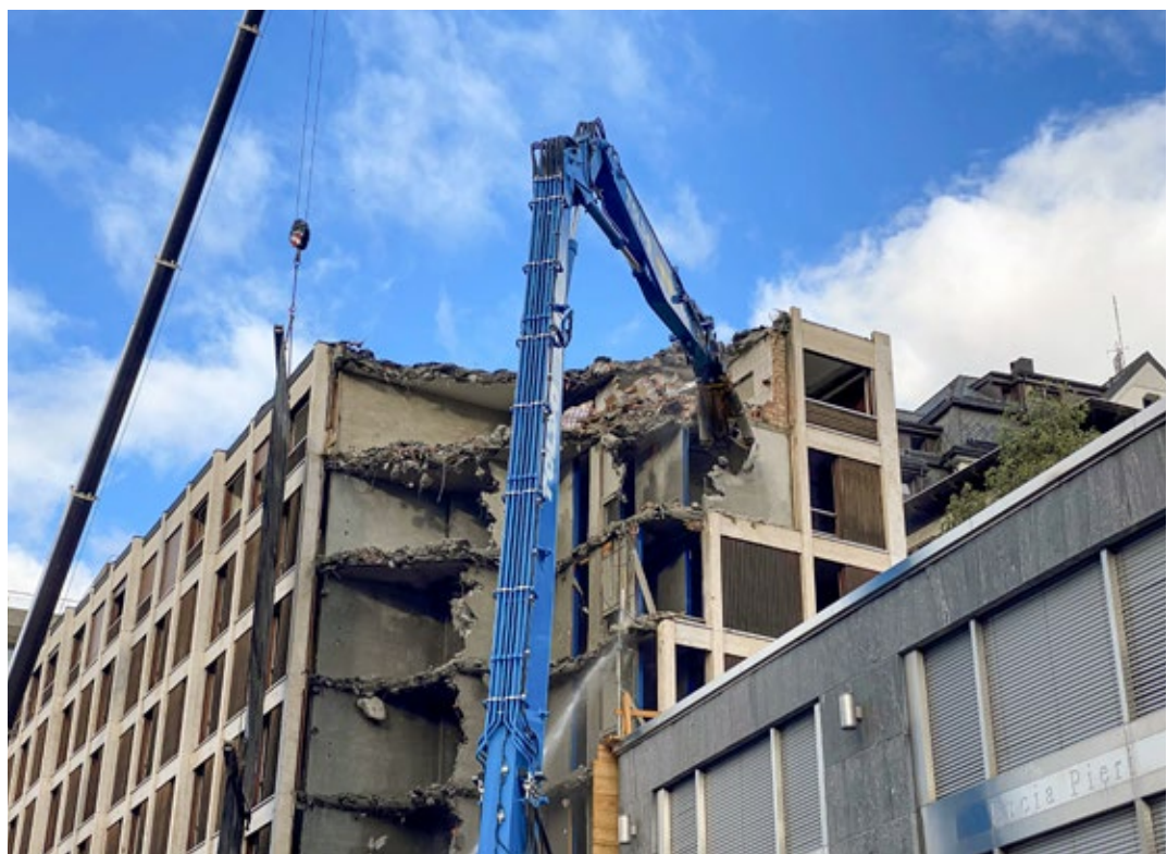
Rückbau Neue Alpenrose (Foto: Bauamt St. Moritz, Daniele Rogantini)
