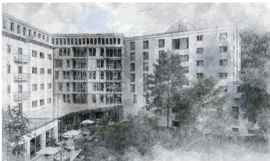
links: Engadinerhof, Mitte: Mitteltrakt (neu), rechts: Metropol
