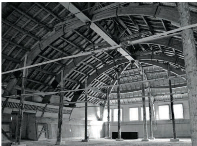
Unterstützte Hallenkonstruktion. Untersicht des Dachs mit Sparren, Pfetten und Binder (Bündner Monatsblatt 4/2019)
