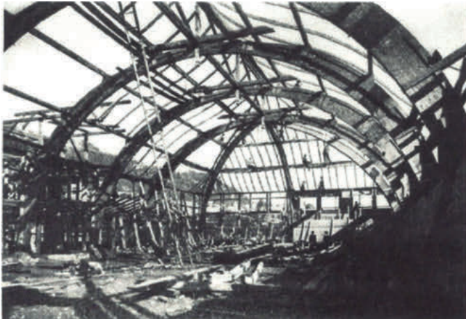
Reithalle St. Moritz, Bauzustand
